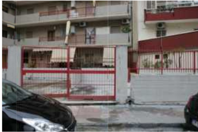
Foto 1: Ingresso alla pertinenza scoperta da Via P. Stellacci 7
