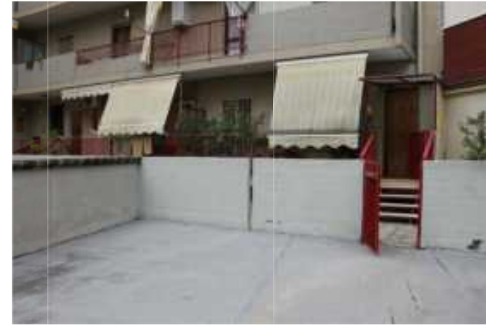
Foto 3: Pertinenza scoperta ad uso esclusivo
