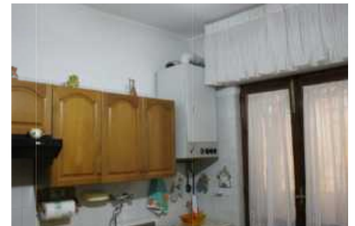
Foto 8: Generatore di calore e produzione Acs
