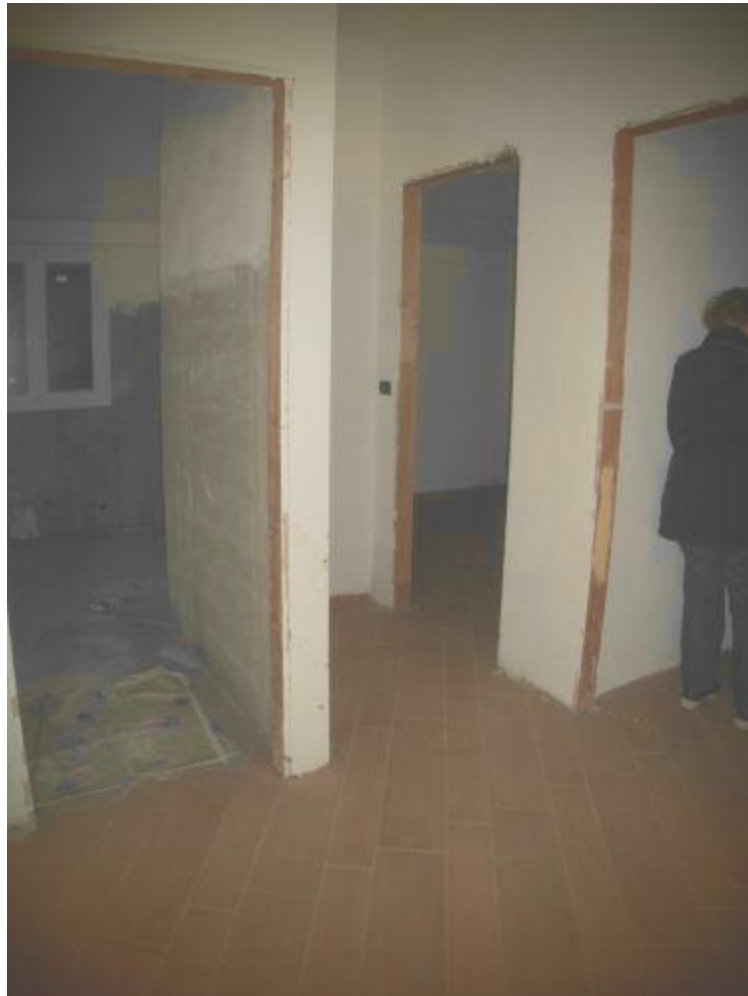
FOTO N° 2-3-4: SERVIZIO IGIENICO - SCALA INTERNA - DISIMPEGNO
