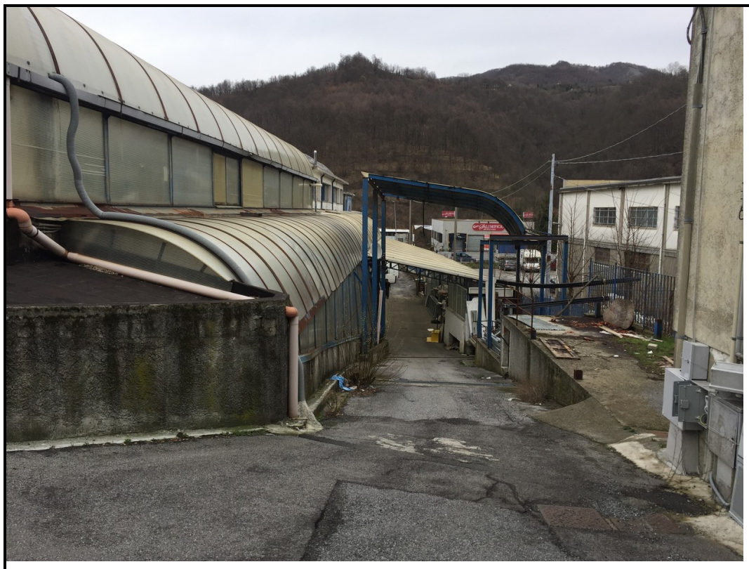
Foto 15 – particolare rampa accesso
