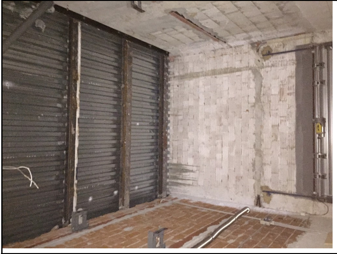
Foto 11 – l'ex montacarichi con la chiusura orizzontale
