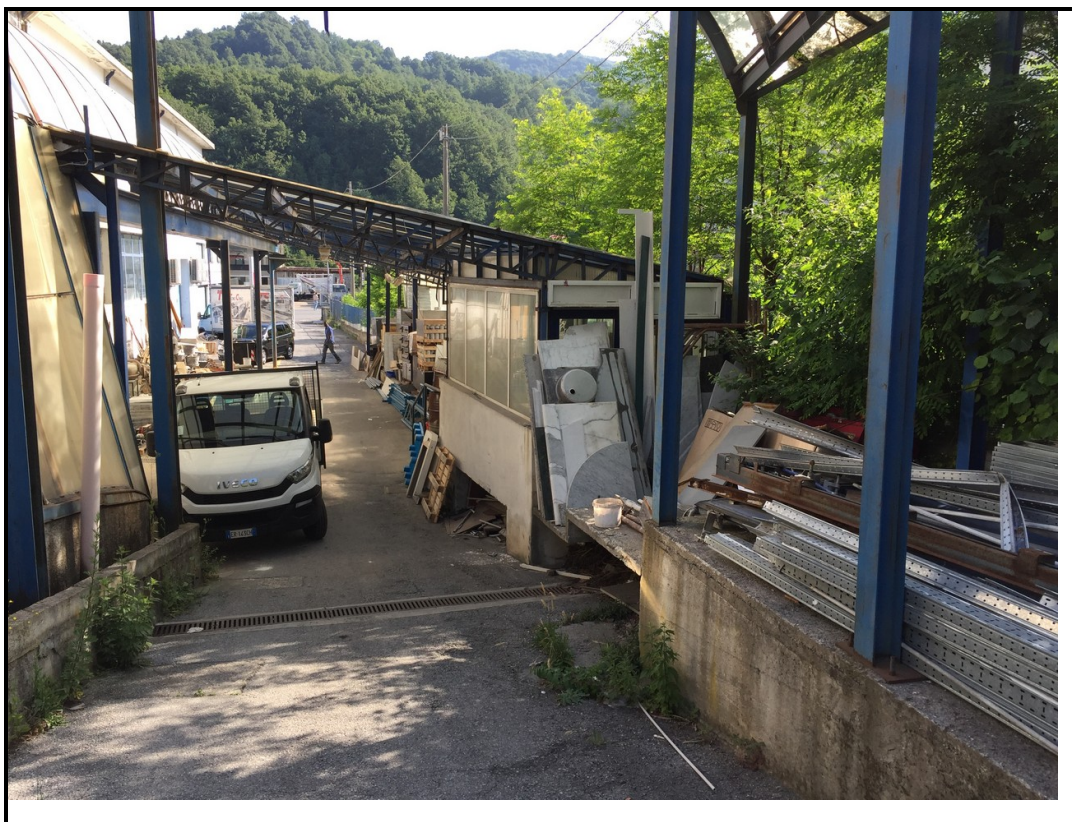
Foto 14 – rampa di accesso al soprastante Lotto 3° (Go-Kart)
