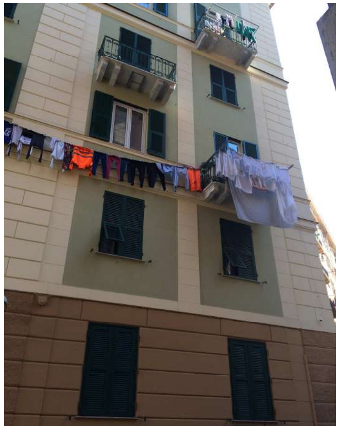
Particolare della facciata principale sulla traversa privata da via G.B.Monti.
