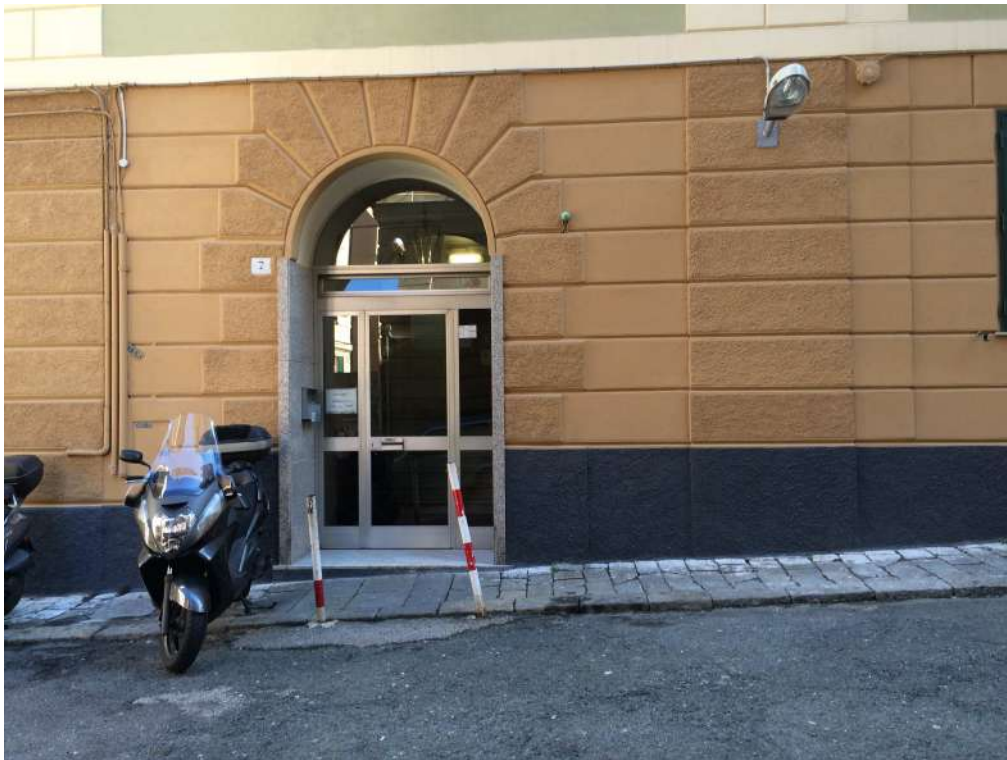
Vista del portone condominiale.
