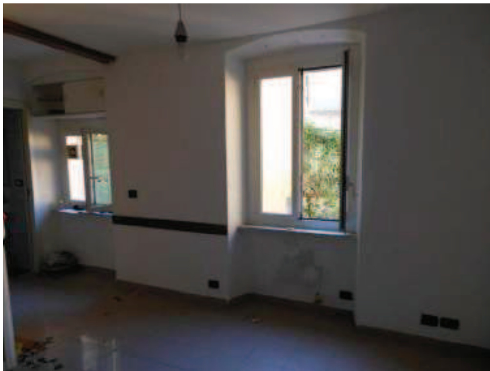
Fotografia n. 15 – particolare affaccio su cavedio
