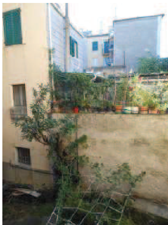
Fotografia n. 16 – particolare affaccio su cavedio
