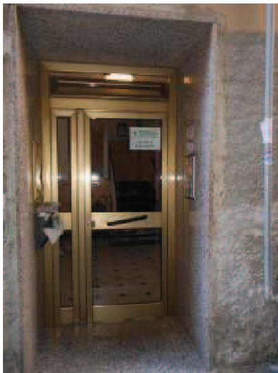
Fotografia n. 3 – particolare del portone del caseggiato
