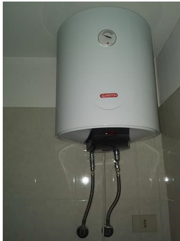
Foto 18: bagno, boiler elettrico
