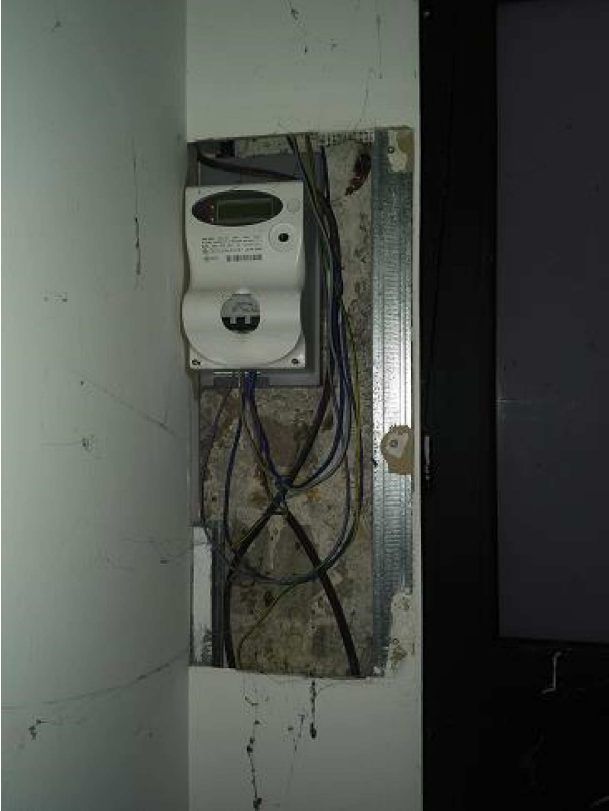
Foto 19: ingresso, contatore elettrico
