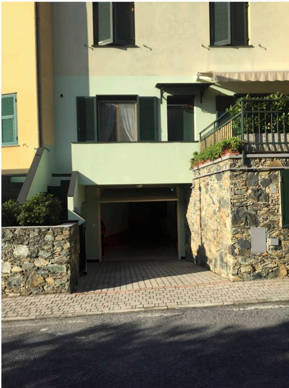
foto 11 - ingresso autorimessa su Via Ciosa
