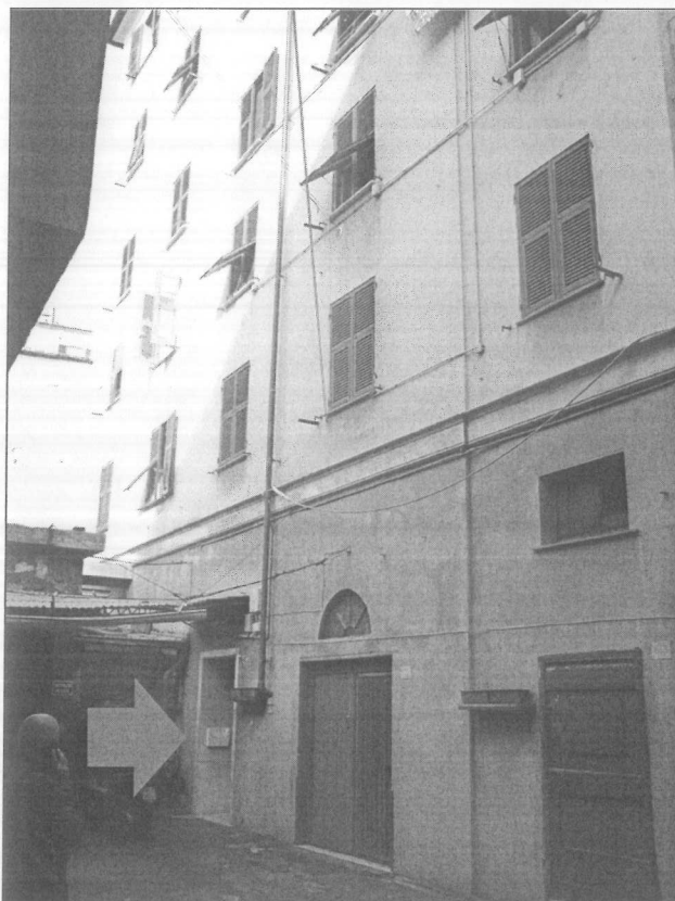
Foto n° 5 – Edificio civico n° 51 della Via Sampierdarena
