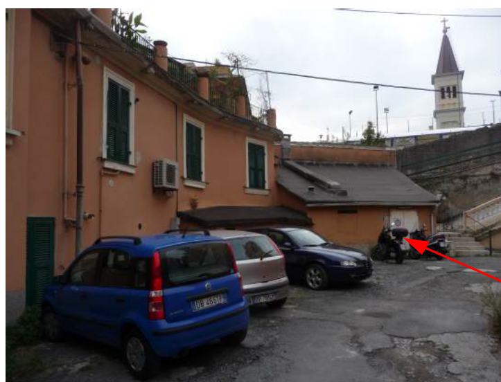
Foto 5. Cortile condominiale e accesso.
