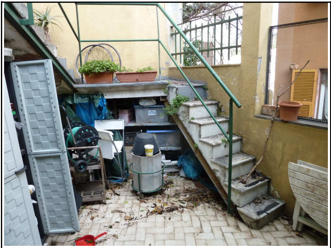
Foto 15 – particolare terrazzino a livello
