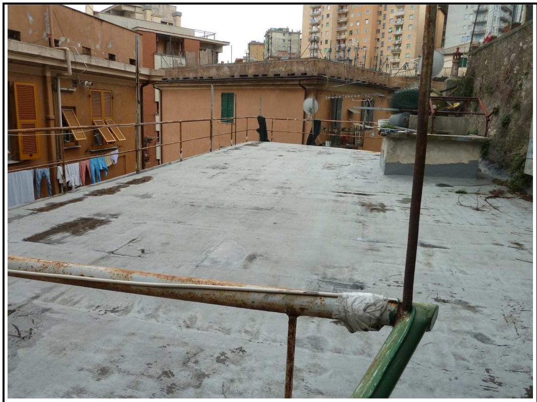
Foto 17 – particolare terrazzo di copertura
