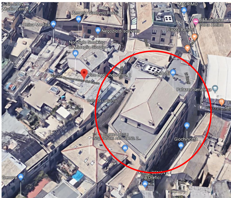
FIGURA 2 – VISTA AEREA FABBRICATO PIÙ AMPIO (PROSPETTO OVEST)
