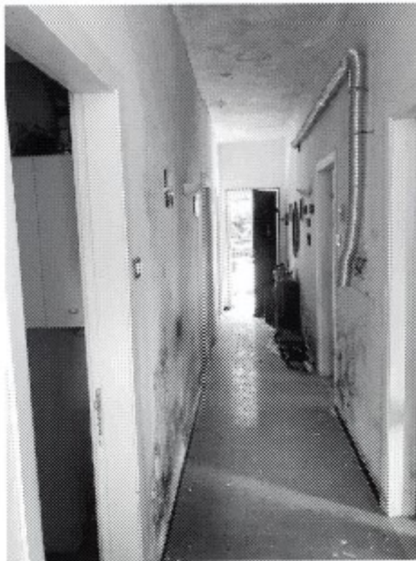
Foto 16 - Vista corridoio - ingresso
