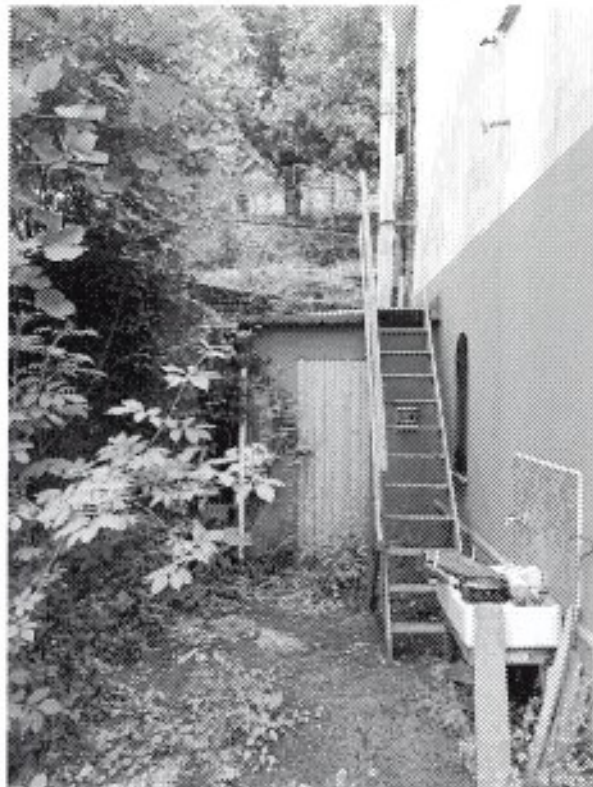
Foto 09 - Facciata nord e locale tecnico
