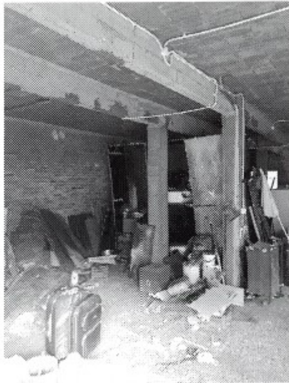
Foto 13 - Vista interna del box
