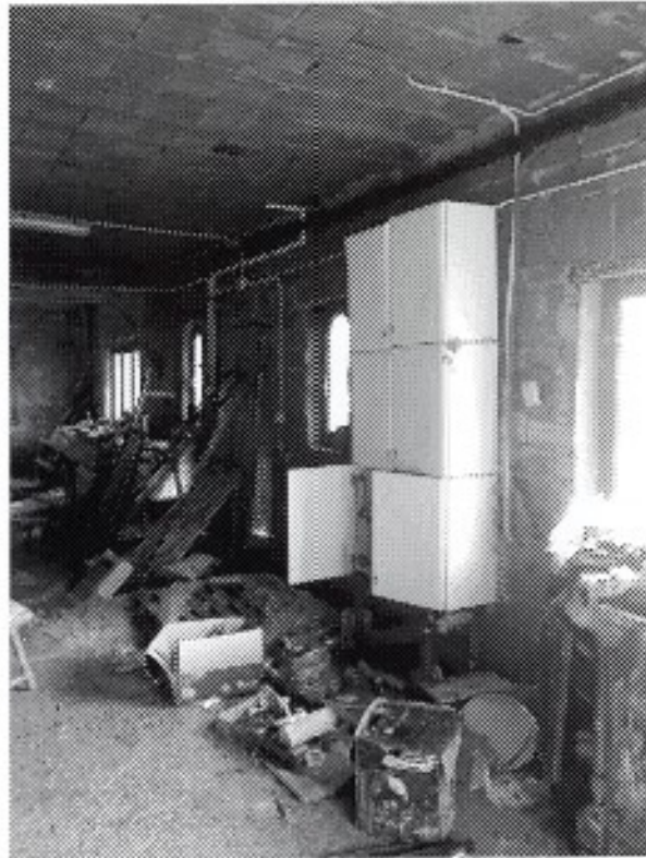
Foto 15 - Vista interna del box
