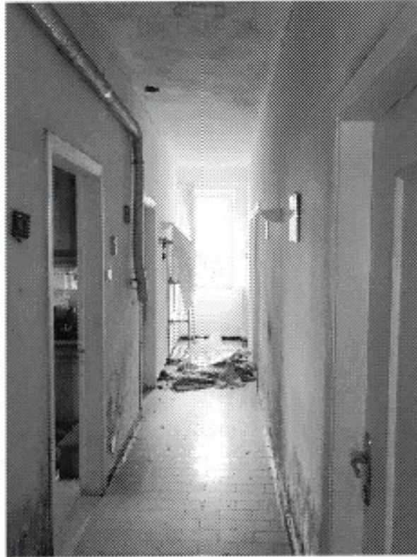
Foto 17 - Vista dall'ingresso - corridoio
