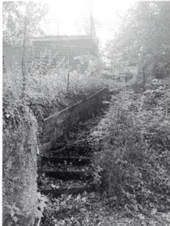
Foto 03 - Accesso al fabbricato dal cancello pedonale
