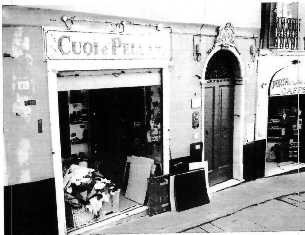
Foto n 2 Ingresso attività commerciale e portone edificio civ. 9
