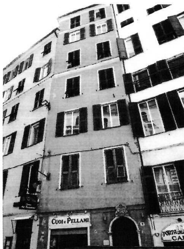
Foto n 1 Edificio sito in Via di porta Soprana n.23R Genova
