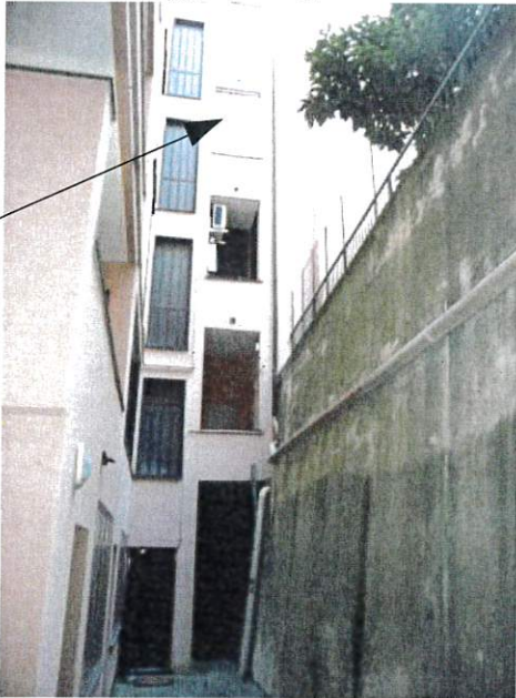
Foto 19. Corte accesso cantine.
