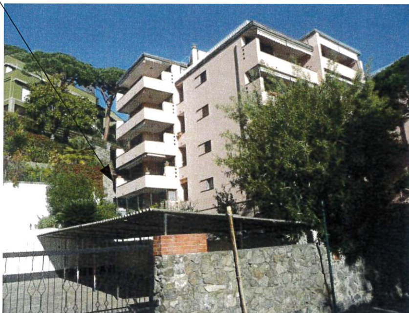
Foto 2. Fabbricato civ. 50 da Via del Mare
