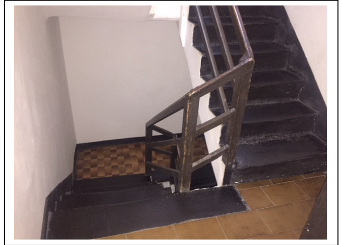
Foto n. 8 : pianerottolo del vano scale
