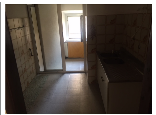
Foto n. 11 : vista cucina e sul retro antibagno del servizio igienico
