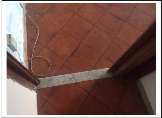
Foto n. 10 : soglia della camera con dislivello
