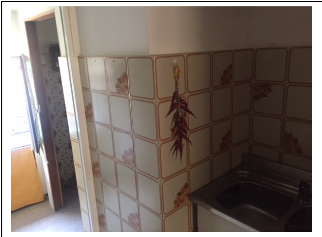
Foto n. 13 : angolo cucina di separazione del servizio igienico
