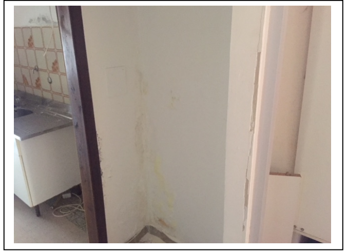
Foto n. 6 : tracce di umidità
