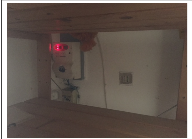
Foto n. 22 : contatore energia elettrica
