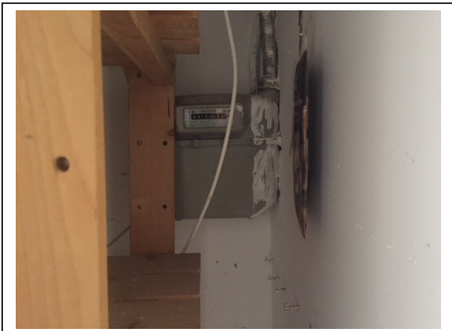
Foto n. 21 : contatore gas nel ripostiglio
