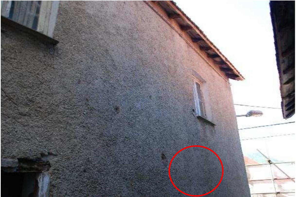
Foto 1 – Prospetto Nord del fabbricato (livello P1-P2)
