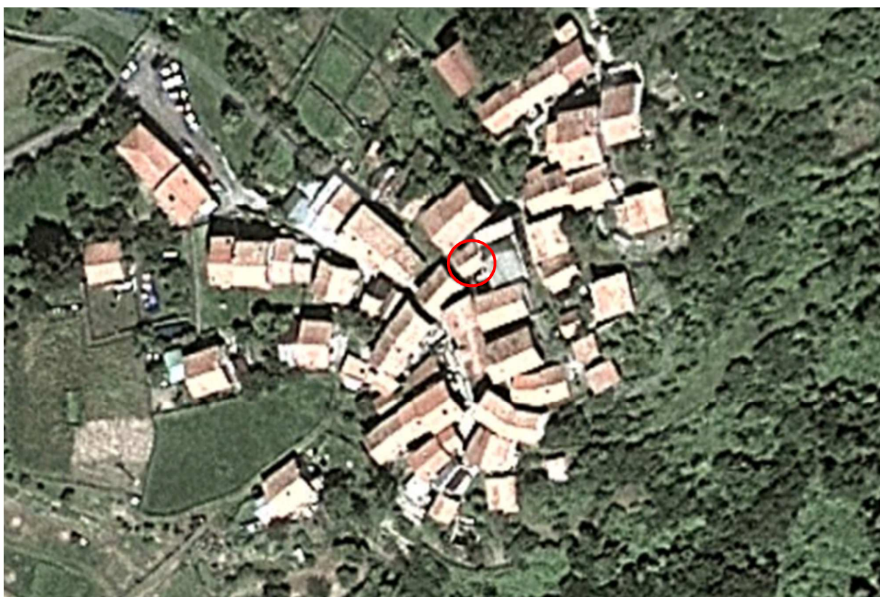
Figura 4 – Vista aerea zona in esame e indicazione fabbricato
