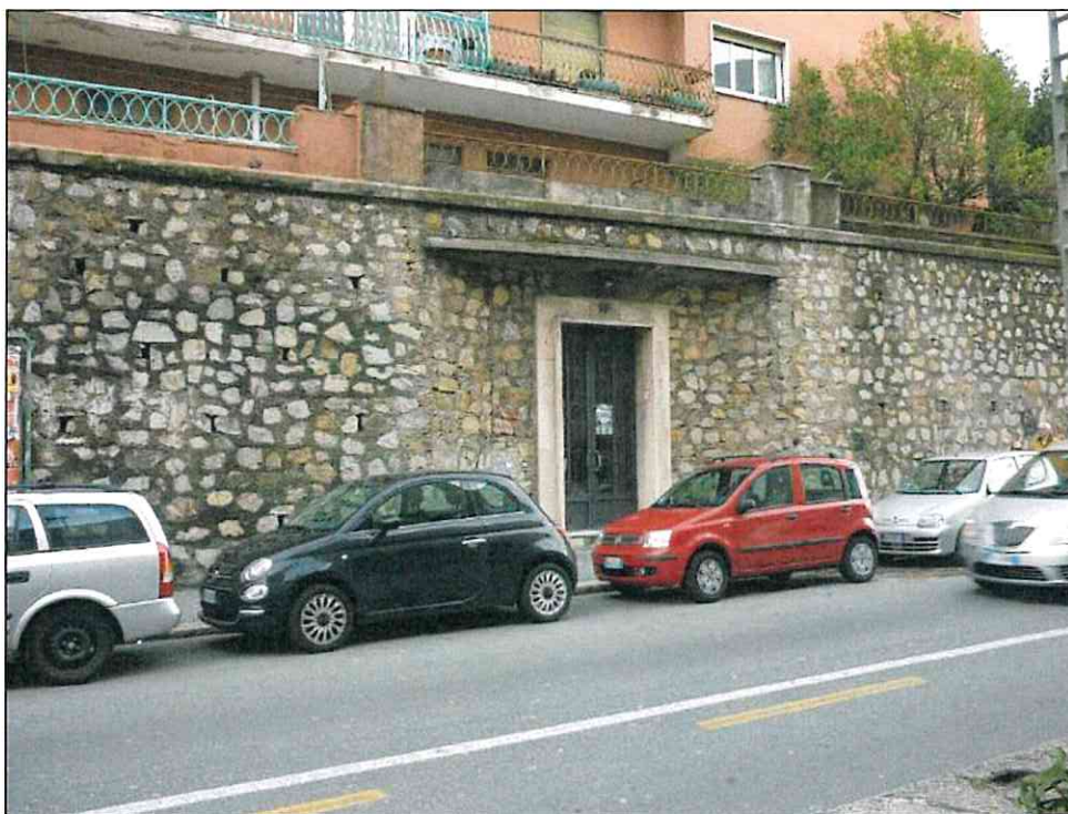
Foto n° 3 – Via Sturla civico n° 58
