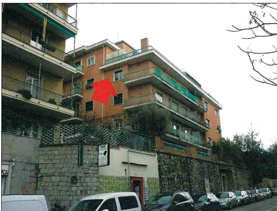
Foto n° 1 – Via Sturla civico n° 58
