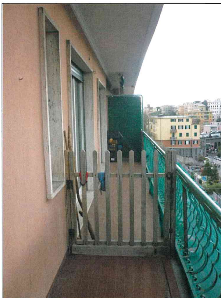
Foto n° 30 – Poggiolo fronte Ovest
