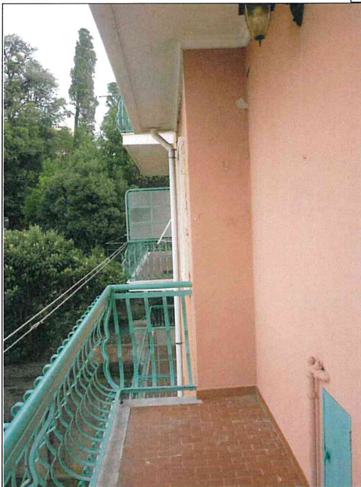
Foto n° 31 – Poggiolo fronte Nord
