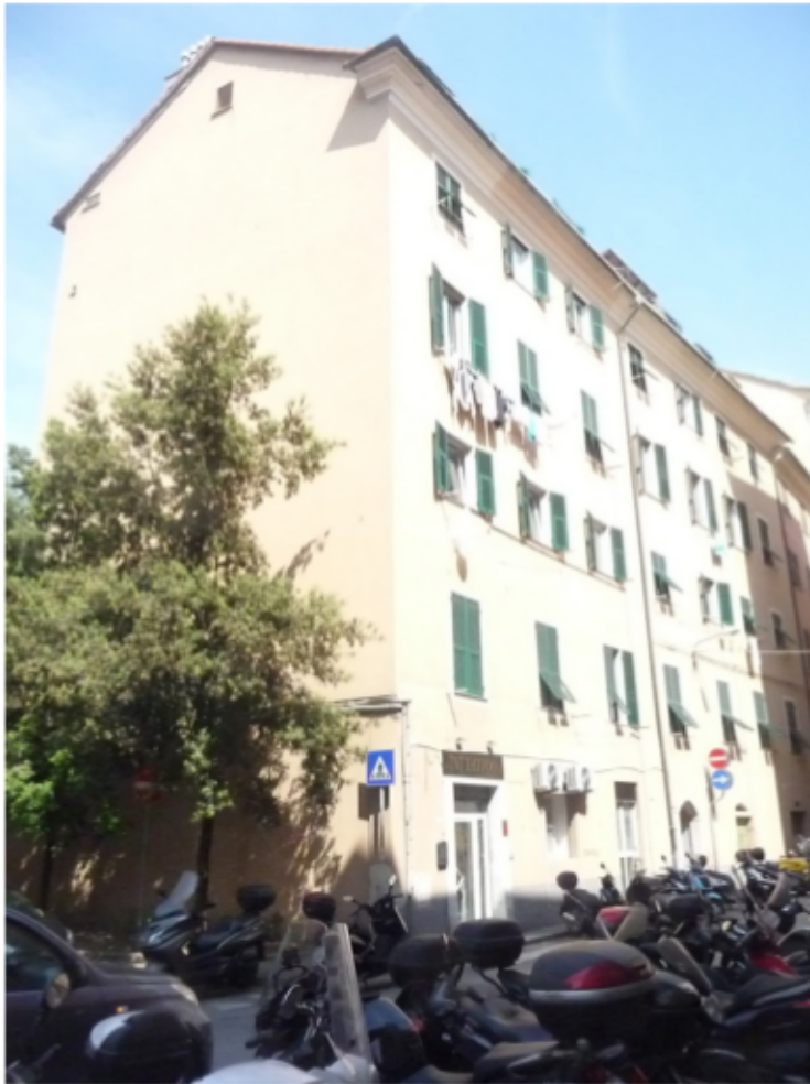
Foto n 1 Vista di edificio sito in Via Bombrini civ n. 5, nel Comune di Genova.
