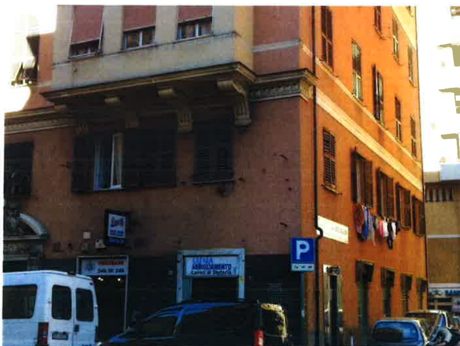
Foto 2. Vista ravvicinata delle due finestre su via Pastorino e 3 laterali.
