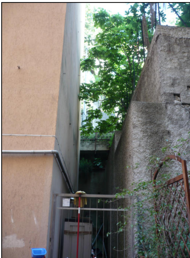
Foto n. 18 – Intercapedine sul lato nord e sul fondo la struttura della foto precedente.
