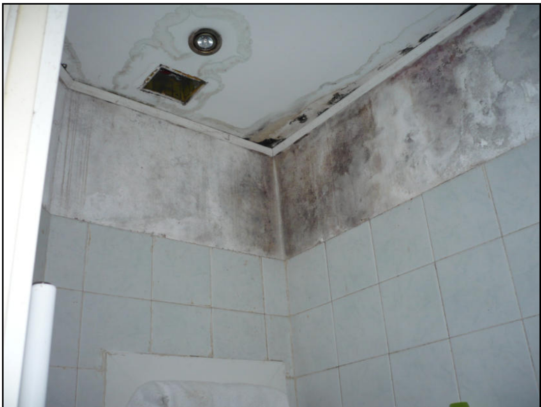
Foto n. 15 – Infiltrazioni e condensa nel locale bagno.
