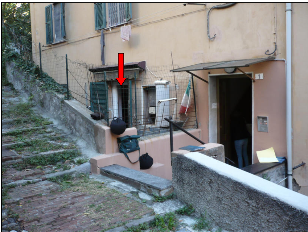
Foto n. 2 – Portone del condominio di salita Bersaglio 1 e dell'adiacente immobile oggetto di stima.
