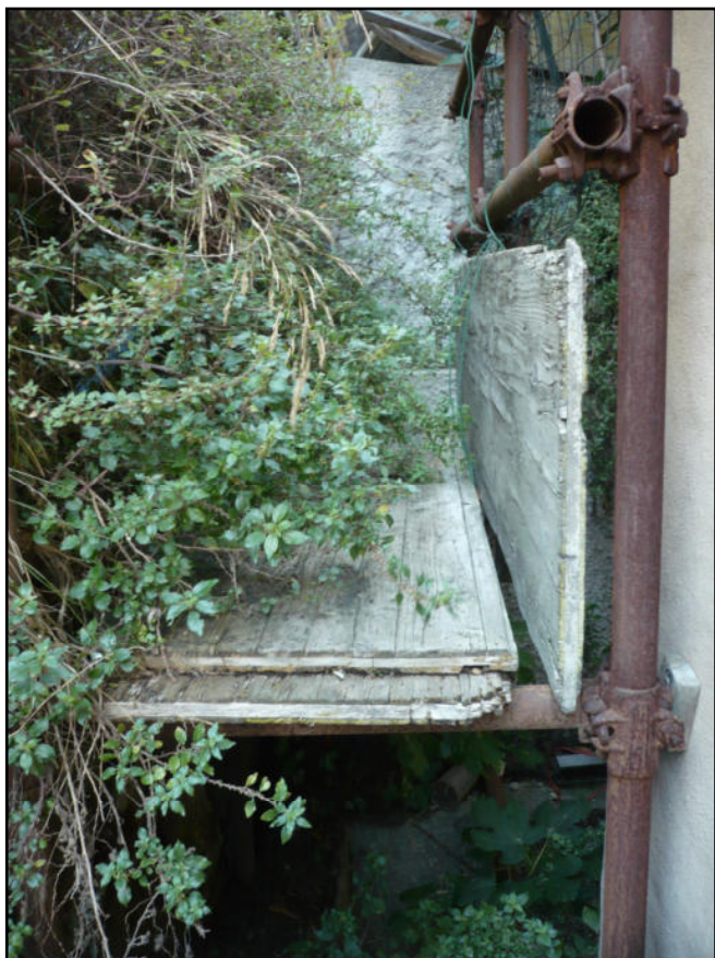
Foto n. 17 – Struttura posticcia per accesso al terreno di pertinenza.
