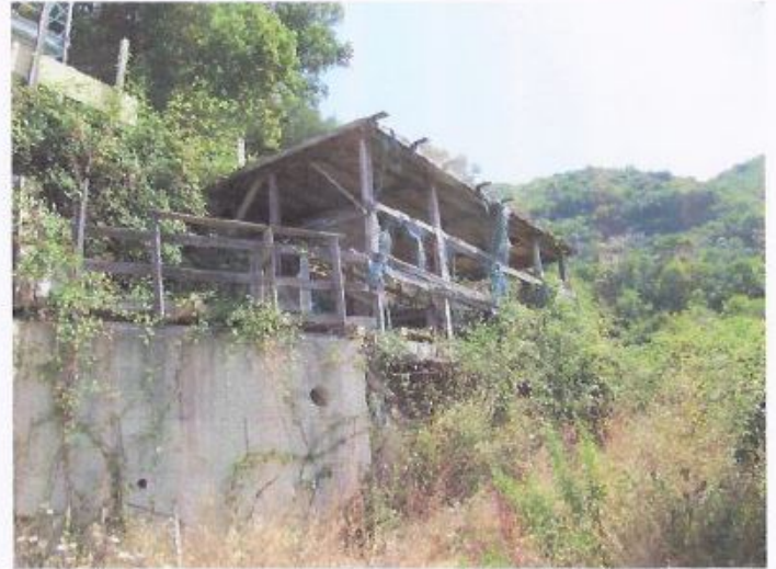
Vista verso la prosecuzione della rampa
