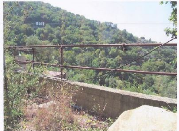
Area esterna dell'edificio in costruzione (piano terra)
