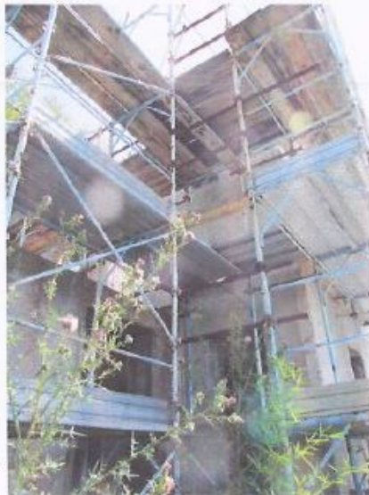
Esterno dell'edificio in costruzione
