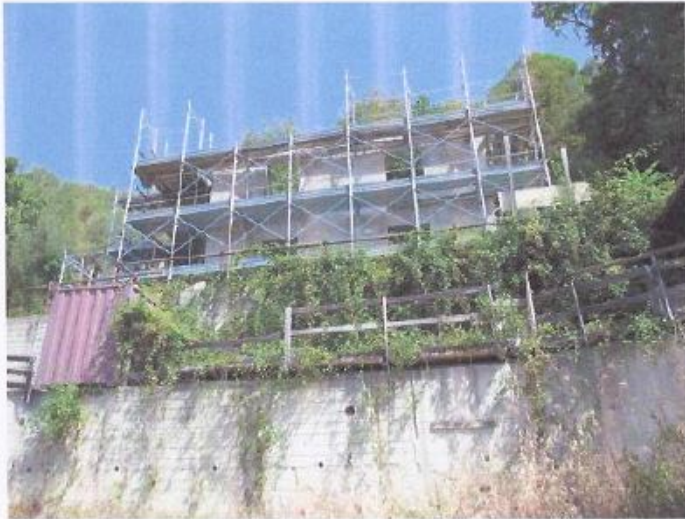
Vista dell'edificio in costruzione
