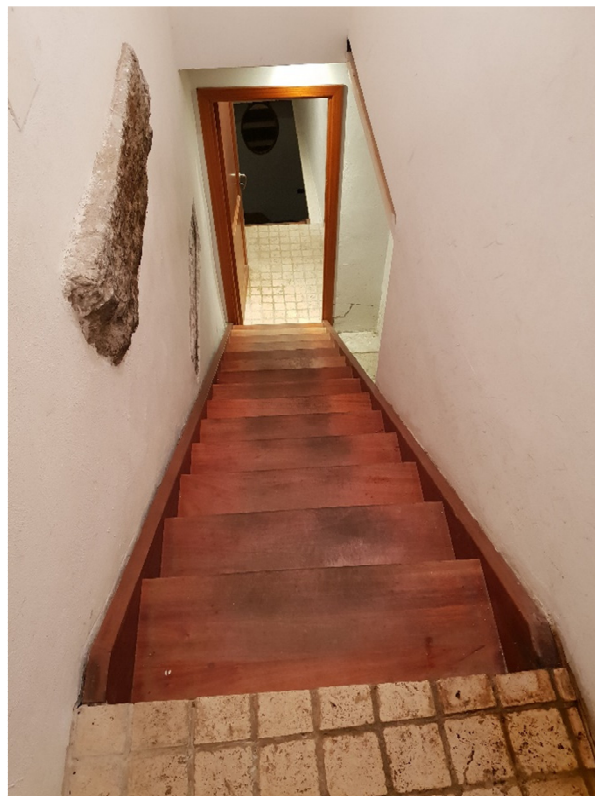
Foto 40: scala di collegamento al sottostante piano ammezzato abusivo
