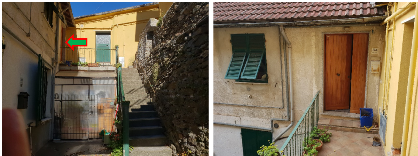
Foto 11-12 : portone d'ingresso civ. 34 di via Fado
