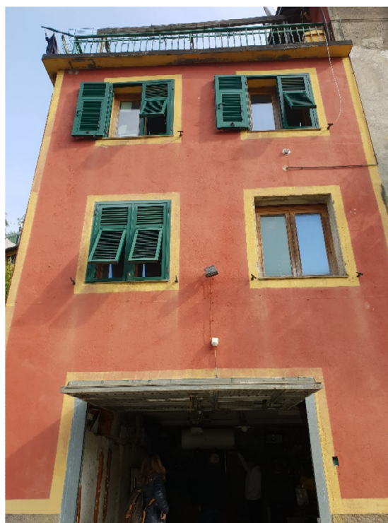
Foto 10: prospetto ovest – ingresso carrabile al locale sgombero piano terra seminterrato
