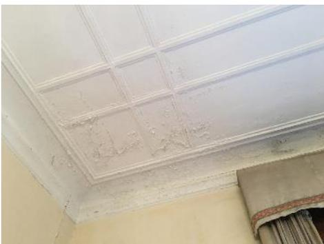
**Locale n.6 (con particolare infiltrazione ormani risolta da piano superiore)**
