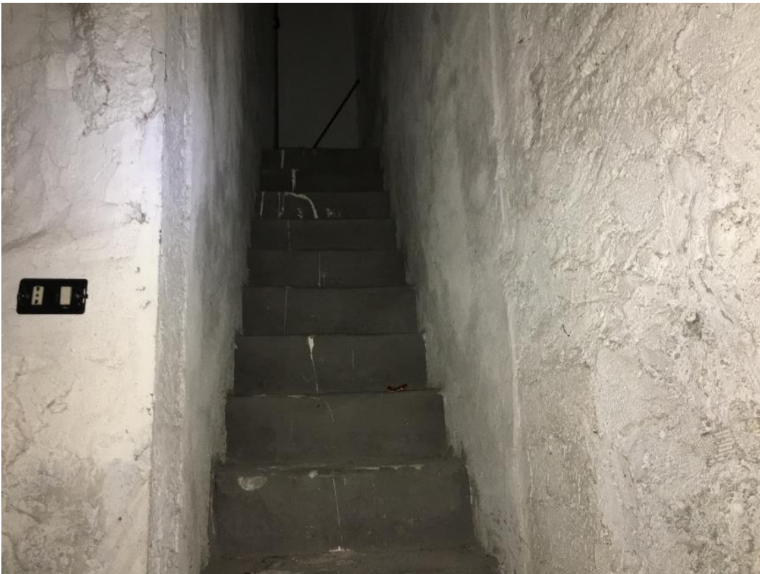
Scala condominiale di Accesso al Piano S1 ove è localizzata la cantina
