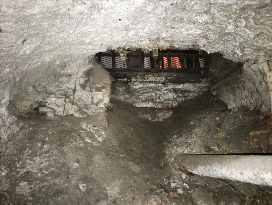
Vista del Locale: Particolare della Finestrella localizzata al piano strada.
