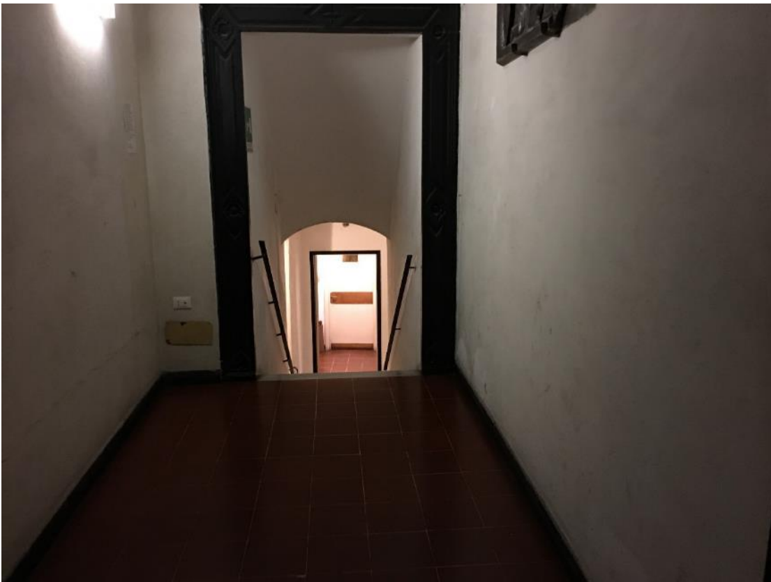
Area Condominiale per l'accesso ai Locali Cantina
