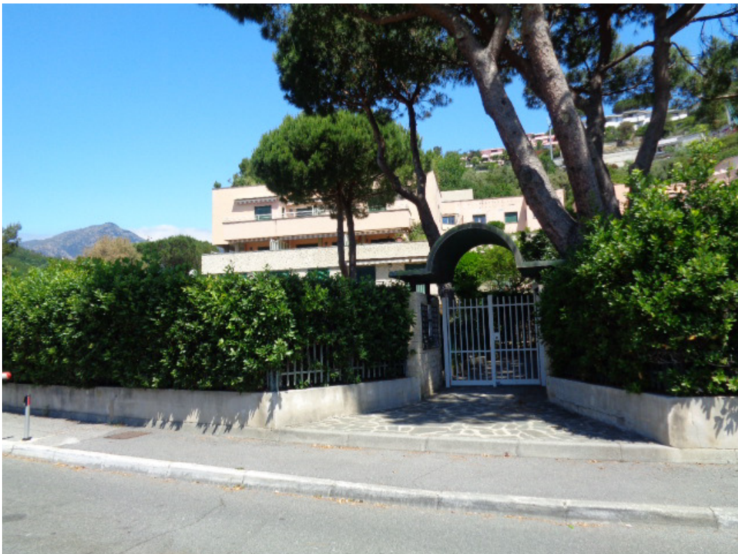
Foto 2: Cancellotto di accesso al giardino
