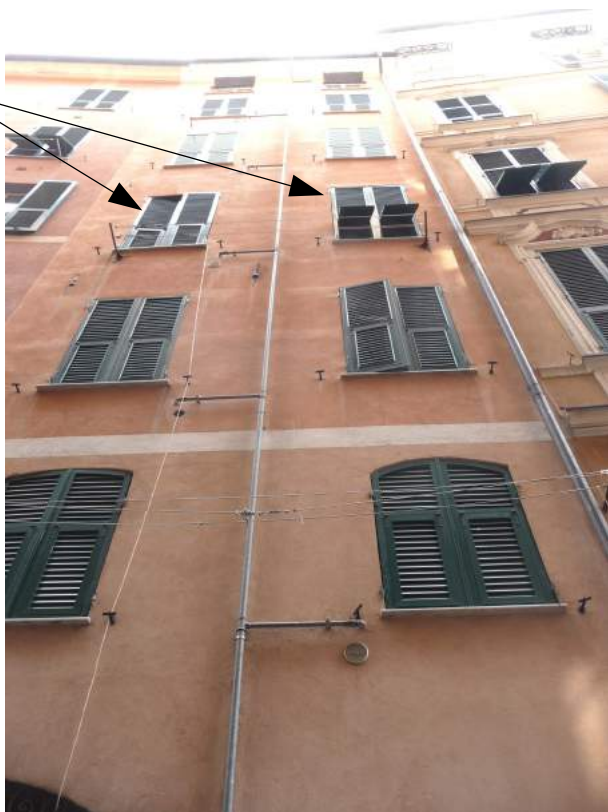
Foto 3. Facciata su Sal. Del Prione
