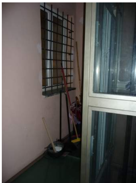
Foto 14. Ascensore e pianerottolo
