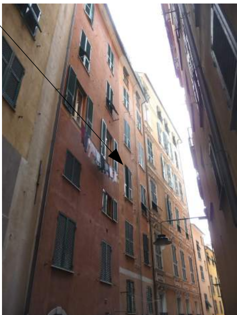
Foto 5. Facciata su sal. del Prione
