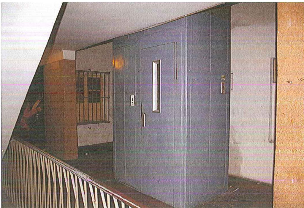
il pianerottolo condominiale sulla destra il cavedio, occupato dall'ascensore
