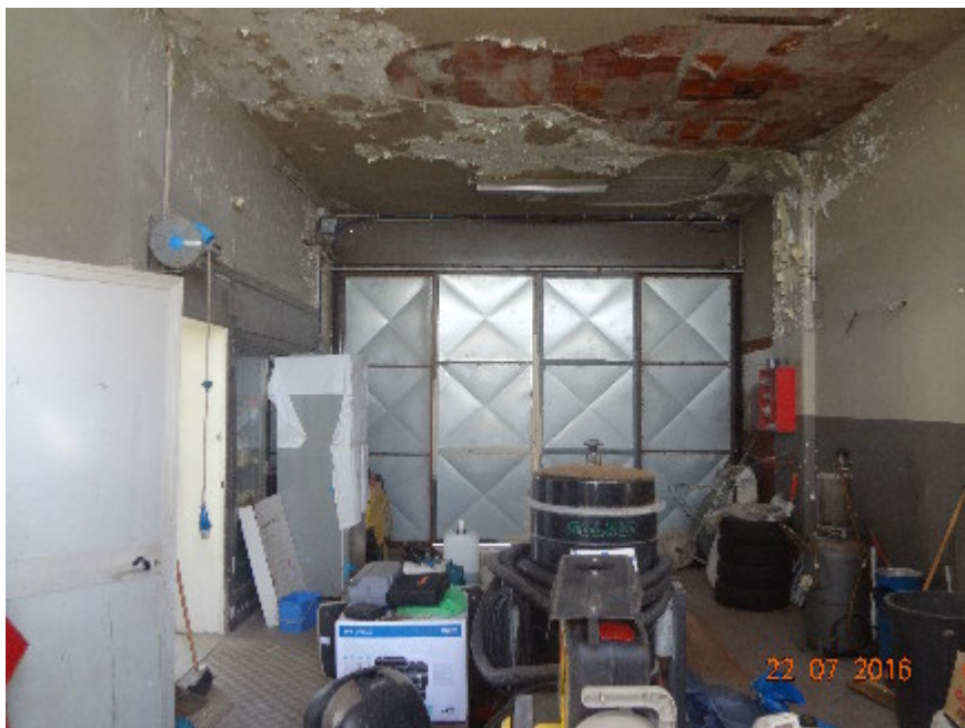
LOCALE ADIBITO A MAGAZZINO
