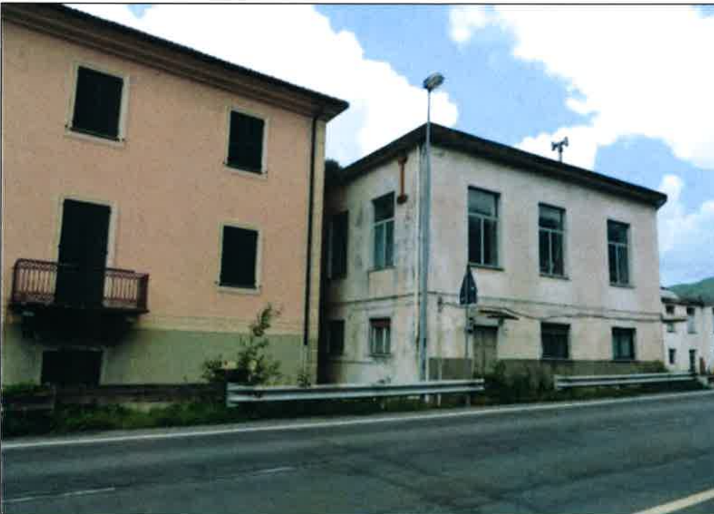
Foto 3 – il fabbricato di via Isola Giugno
