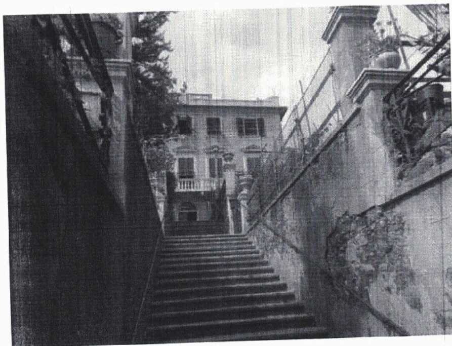
FOTO N° 04 – Prima rampa di accesso
