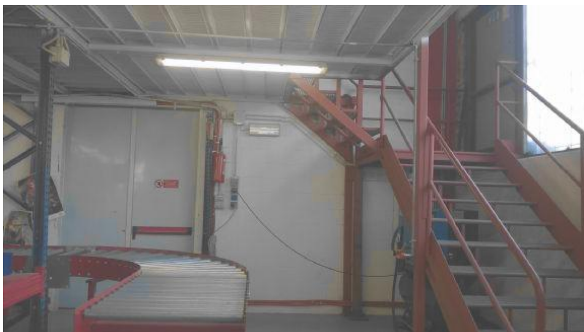
FOTO N° 6-7 - U.S. SOPPALCO E SCALA DI ACCESSO AL SOPPALCO
