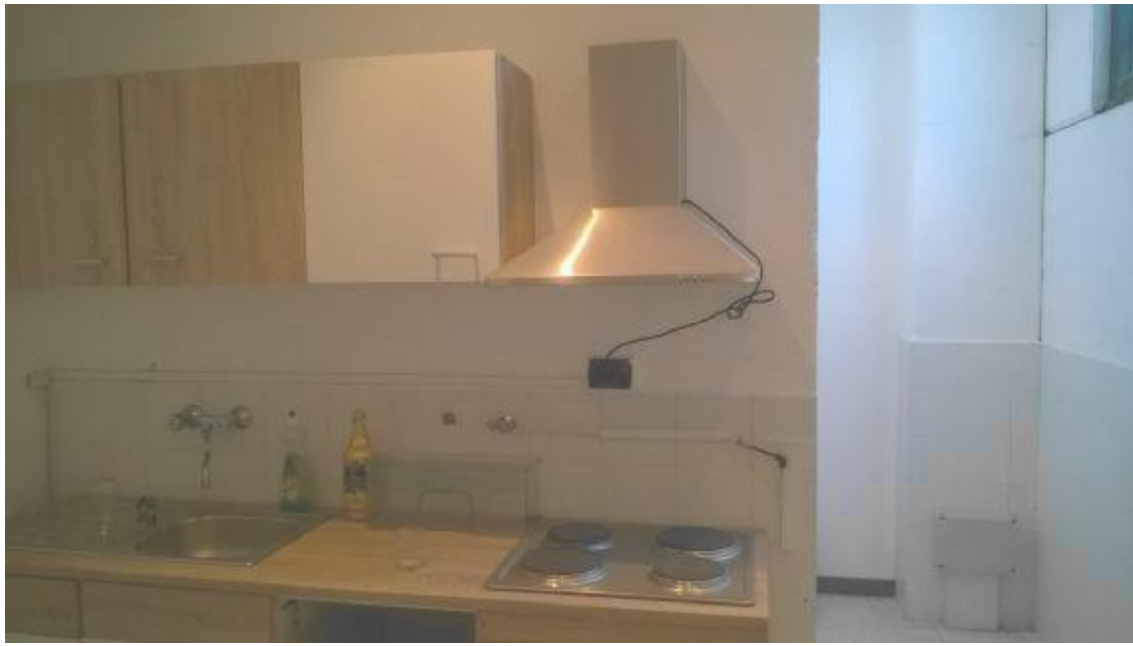
FOTO N° 24 PIANO TERRA CUCINA
