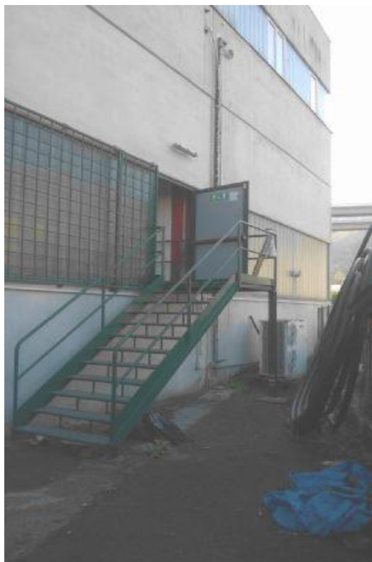
FOTO N° 5 – USCITA DI SICUREZZA PIANO AMMEZZATO (SOPPALCO)
