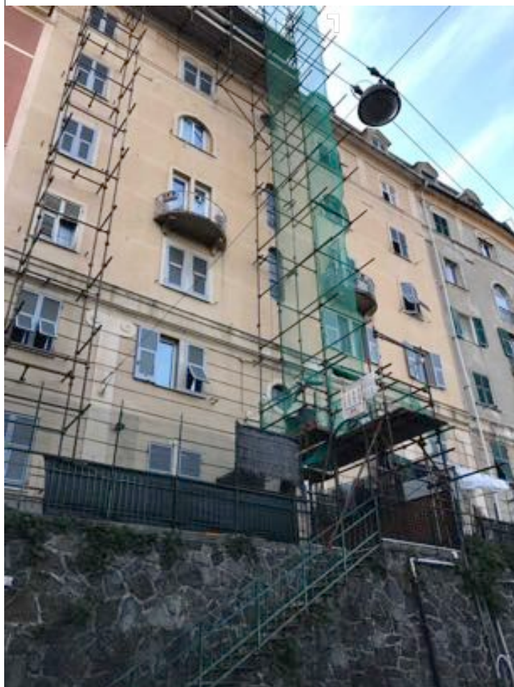
FACCIATA NORD dell'edificio
