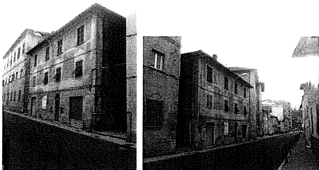
Foto 1 e 2: Prospetto Est
