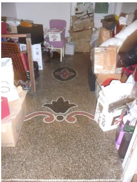
Foto 17. Stanza accessibile dall'ingresso
