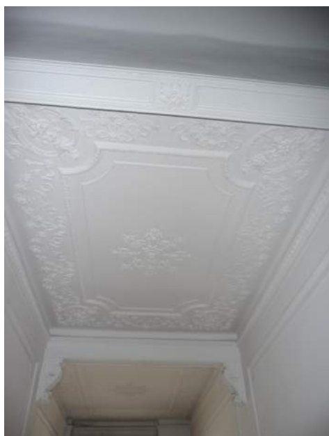
Foto 9 . Soffitto androne di ingresso
