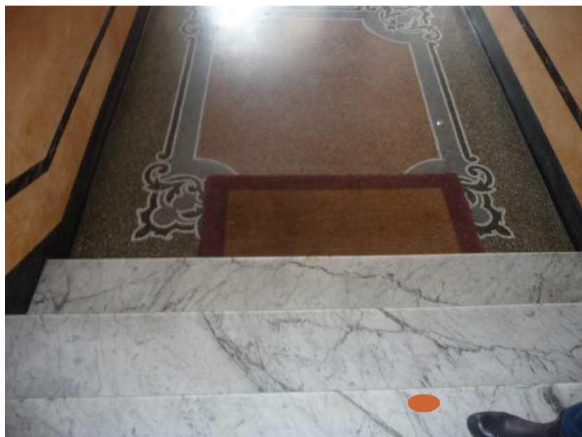
Foto 10. Pavimento androne di ingresso
