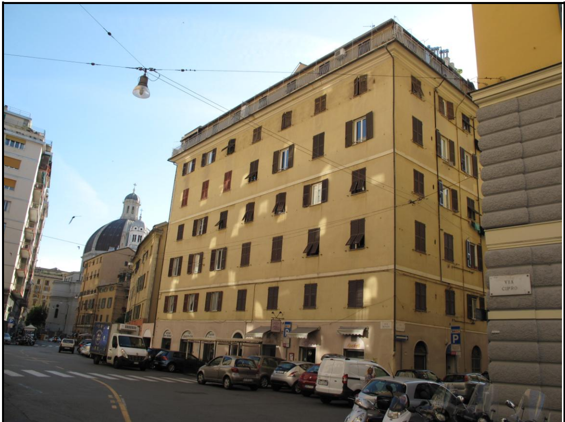
Foto 2 – prospetto su via Rionale
