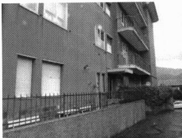
FOTO 1 – Vista esterna immobile
