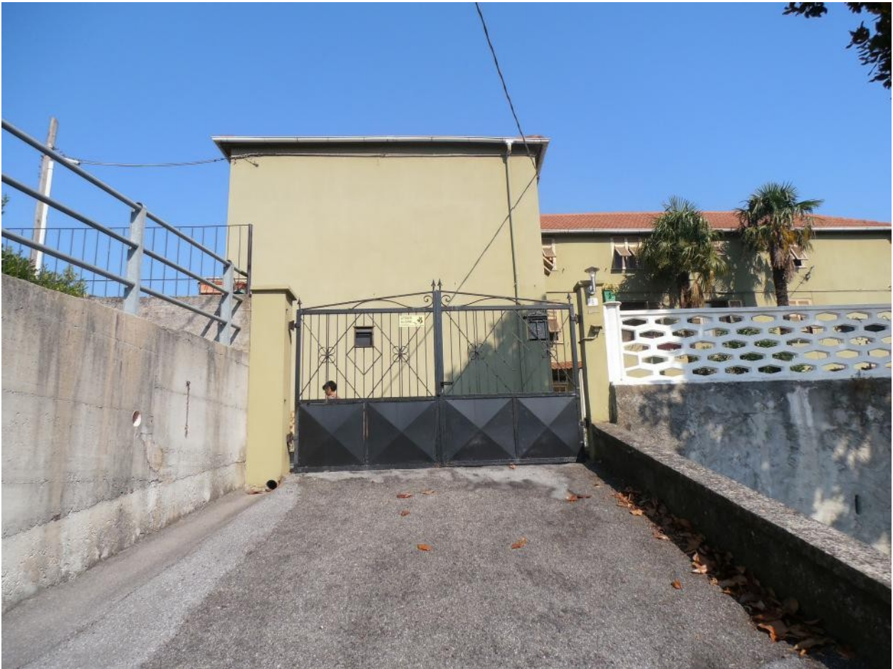
CANCELLO D'ACCESSO AL CONDOMINIO
