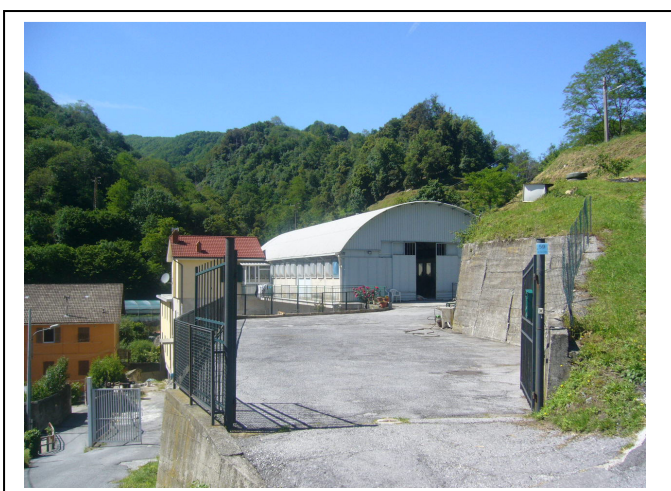
Foto n. 5 : Complesso immobiliare civ. 57 ora 59
