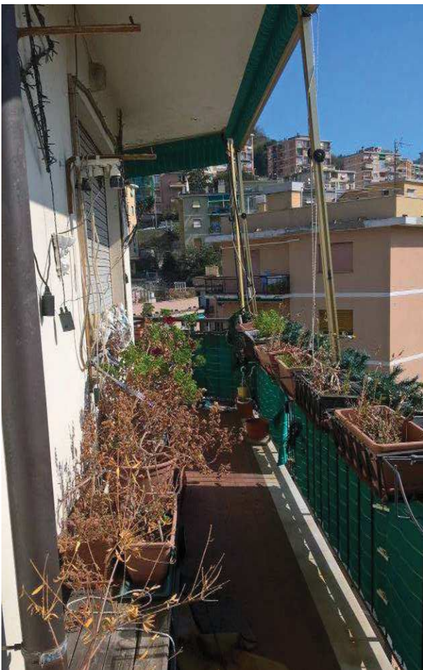
Foto 18 e 19 – Viste del balcone su Via Galeazzo
