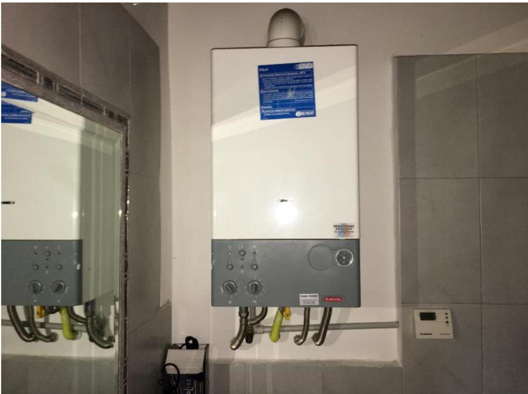
Foto 9: Bagno: particolare generatore di calore riscaldamento e ACS
