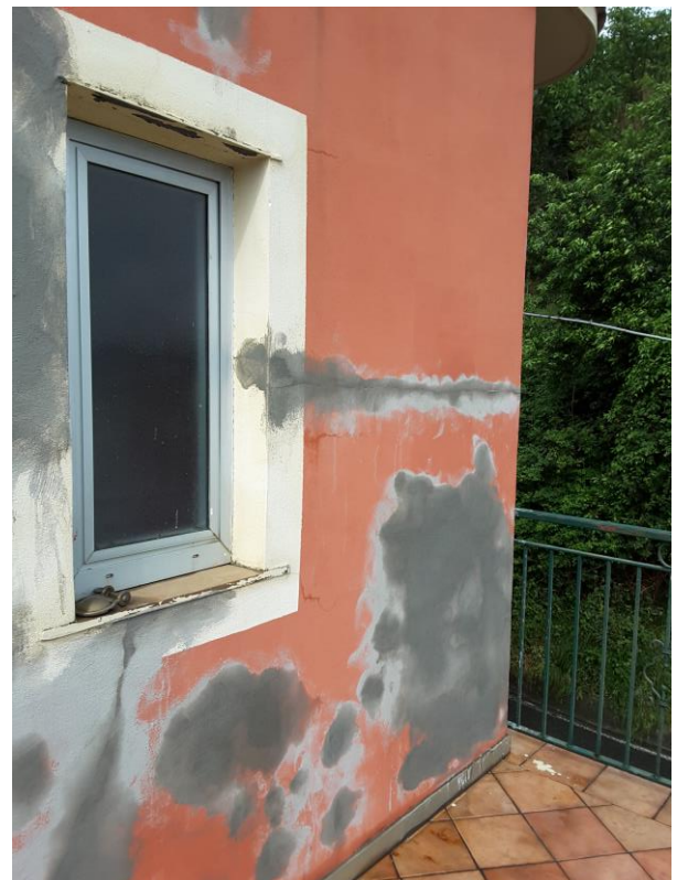
8. Particolare del terrazzo (prospetto sud).
