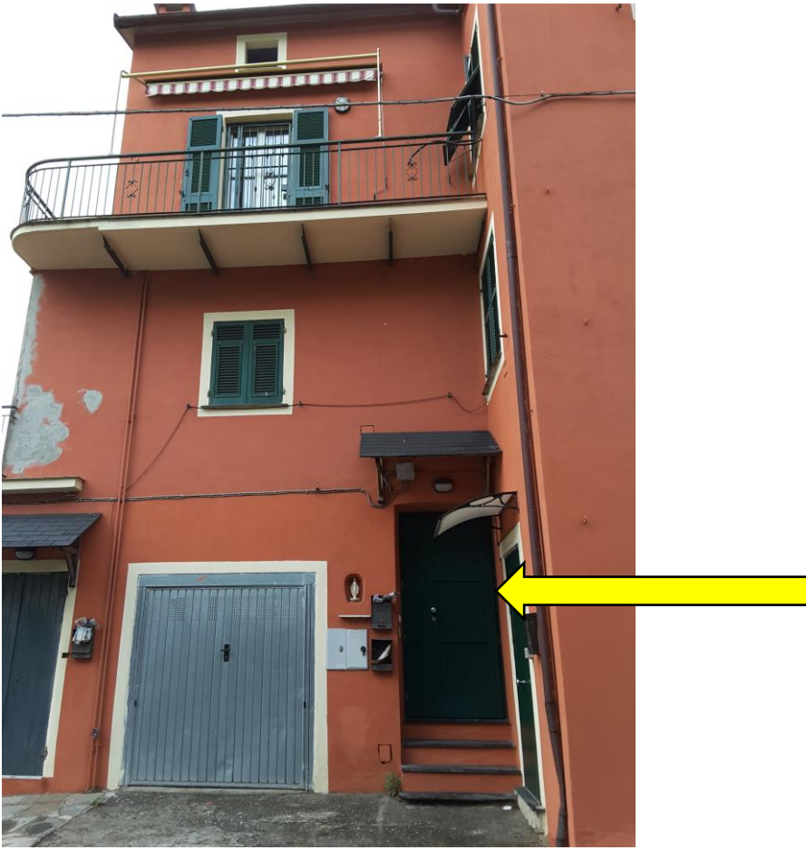
5. Prospetto est, porta d'accesso.
