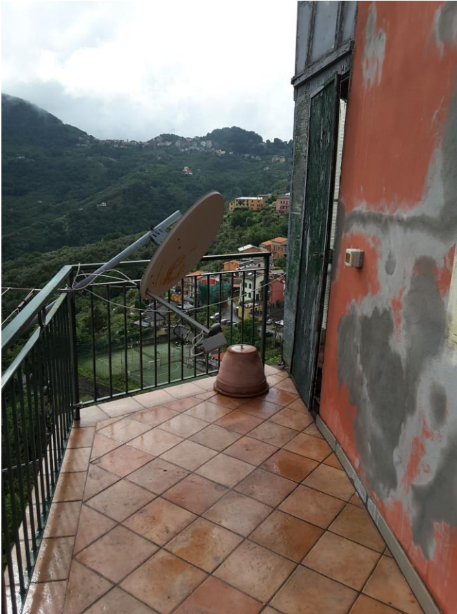
7. Particolare del terrazzo (prospetto sud).
