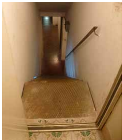
Foto 22 - Vista della scala alle cantine
