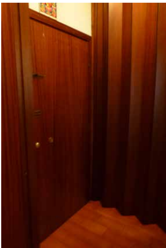
Foto 9 - Vista della porta di accesso all'immobile dall'interno
