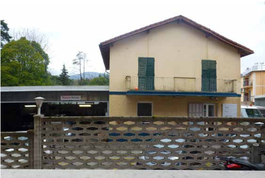
Foto 13 - Vista dalle finestre dell'immobile
