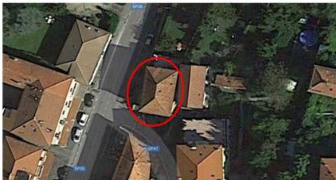
Figura 4 – Vista aerea della zona con indicazione del fabbricato
