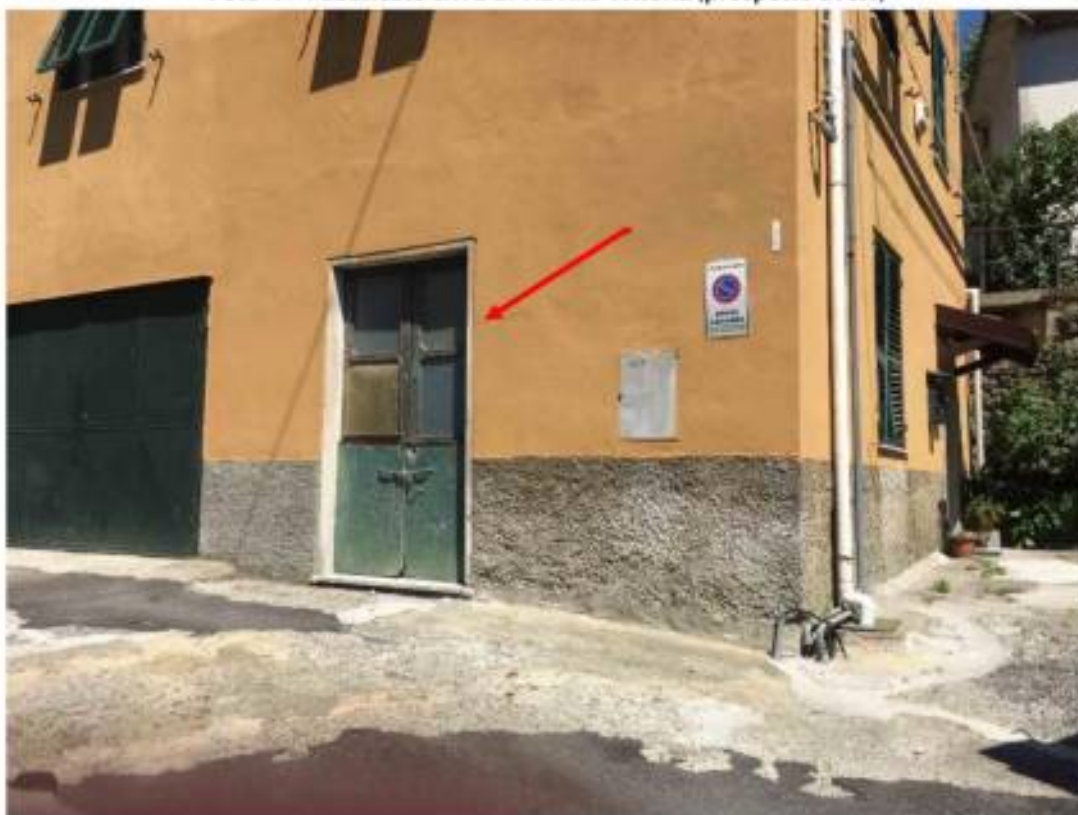
Foto 2 – Cantina annessa all'appartamento sub 7
