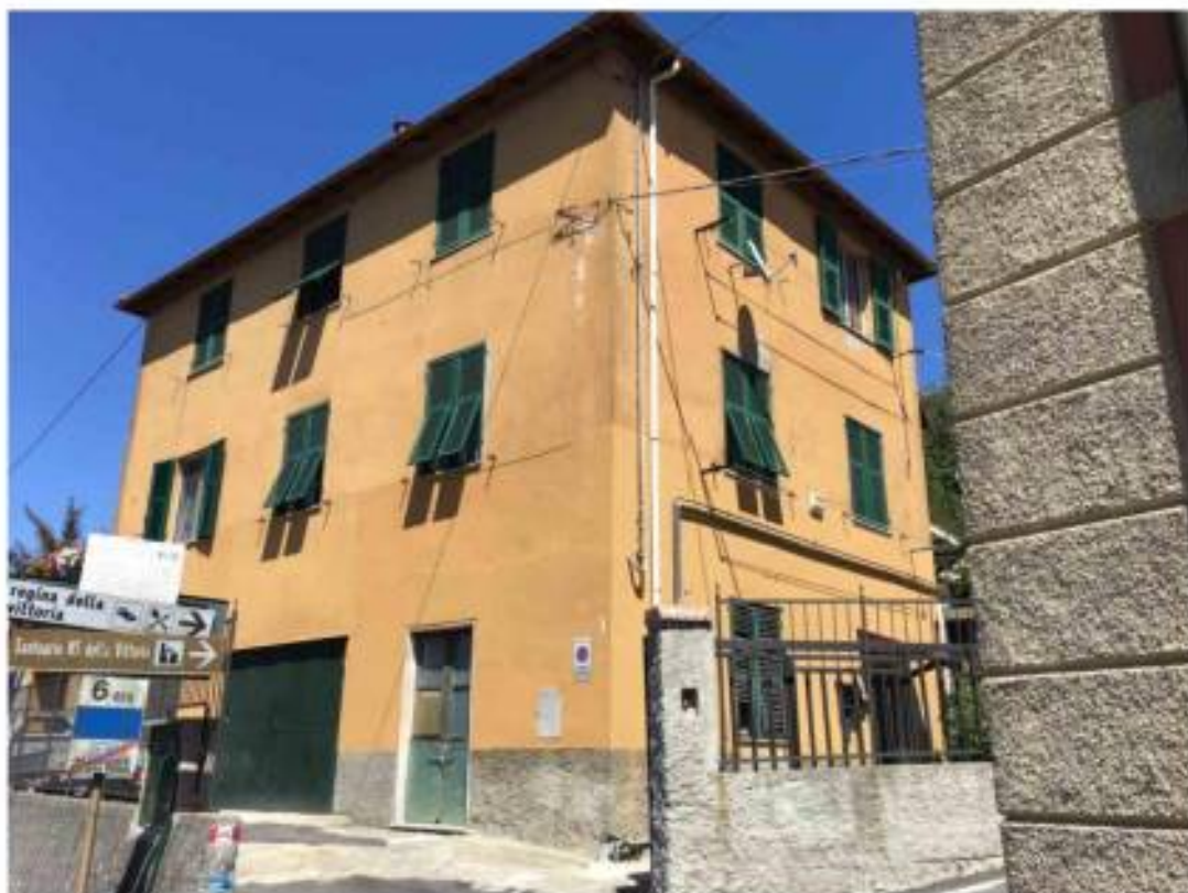
Foto 1 – Fabbricato civ. 2 di Via Alla Vittoria (prospetto ovest)
