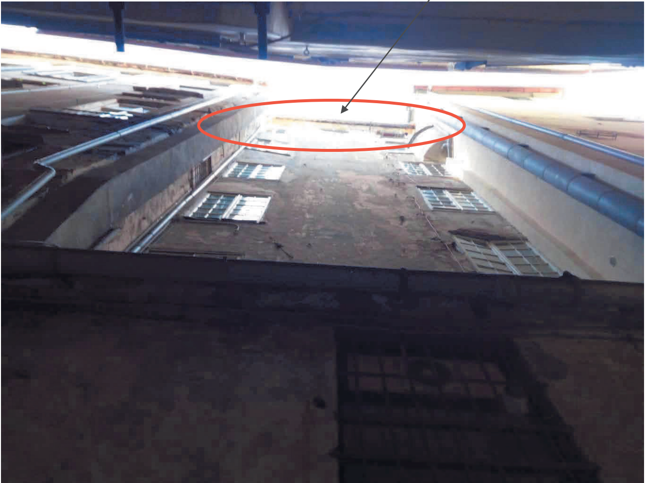
Foto 10) Distacco su vico dell' Amor Perfetto-dettaglio delle bucatore
