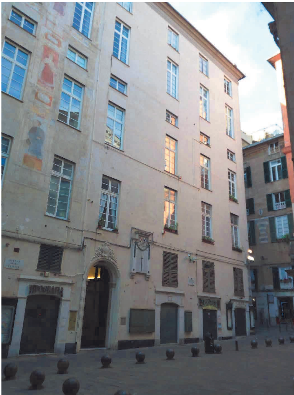
Foto 2) Vista piazza delle Vigne
