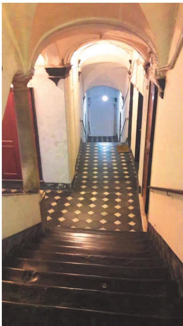
Foto 6) Vano scale SX
