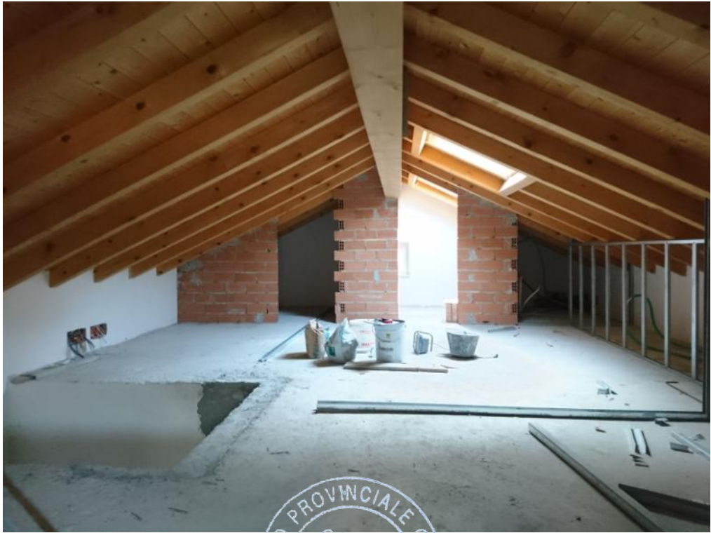
FOTO N° 23: Locale di Sgombero (Piano Sottotetto)
