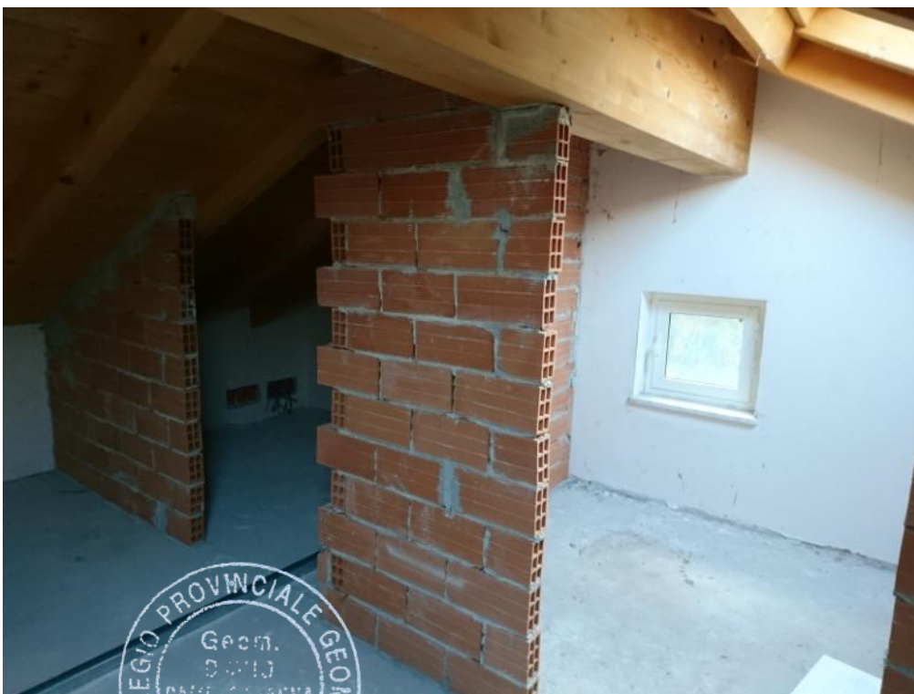
FOTO N° 25: Locali di Sgombero (Piano Sottotetto)
