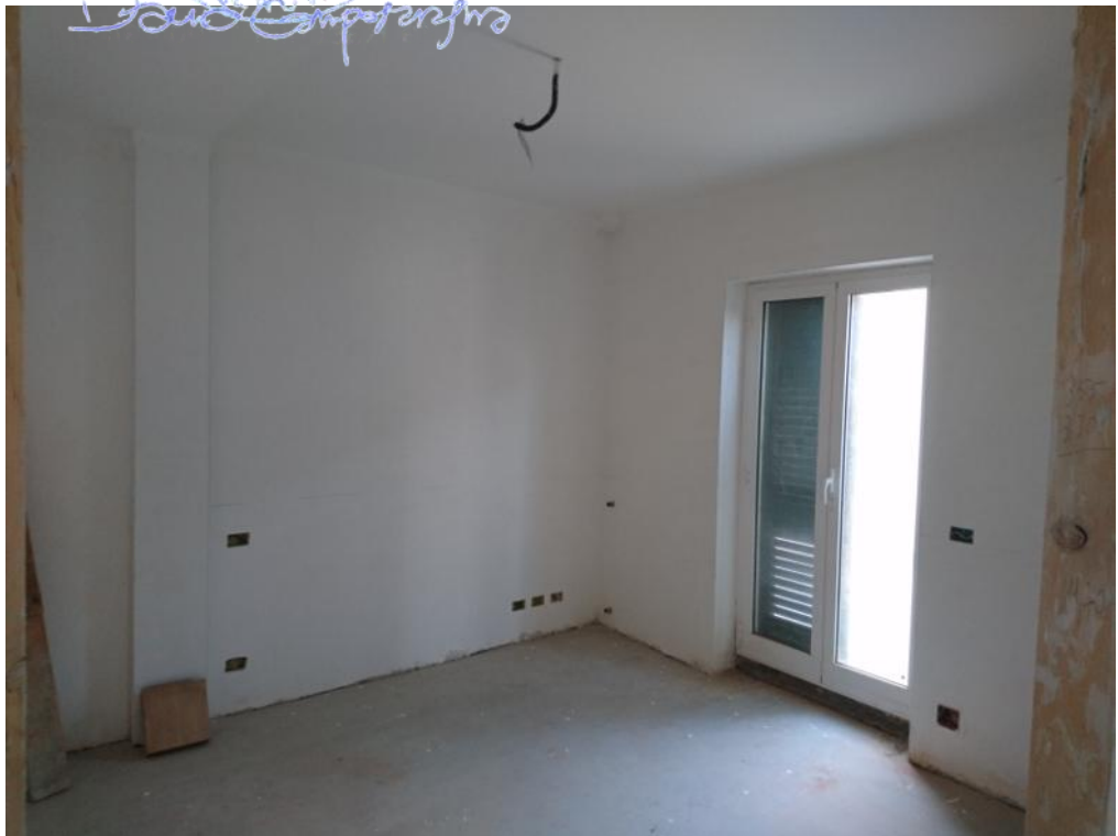
FOTO N°. 18: Camera
