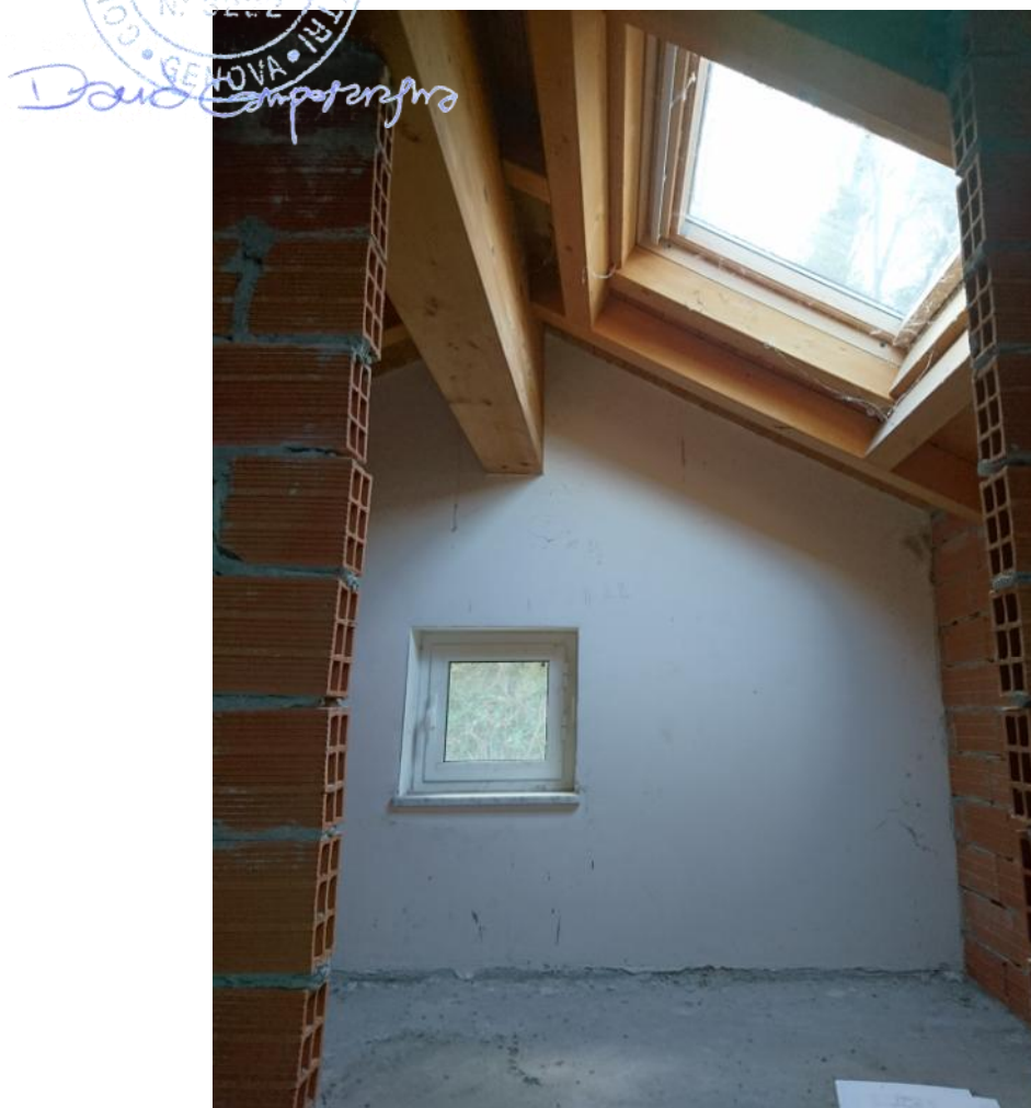
FOTO N° 26: Locale di Sgombero (Piano Sottotetto)
