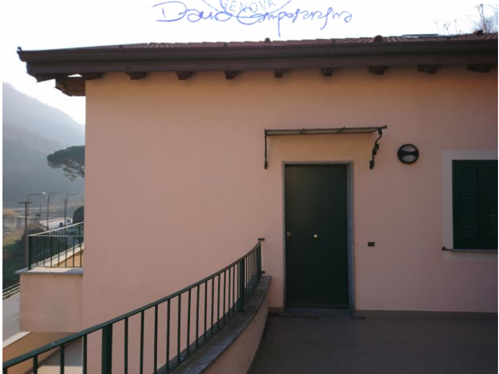
FOTO N°. 8: Porta d'ingresso Interno 9
