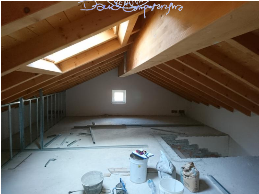
FOTO N° 24: Locale di Sgombero (Piano Sottotetto)
