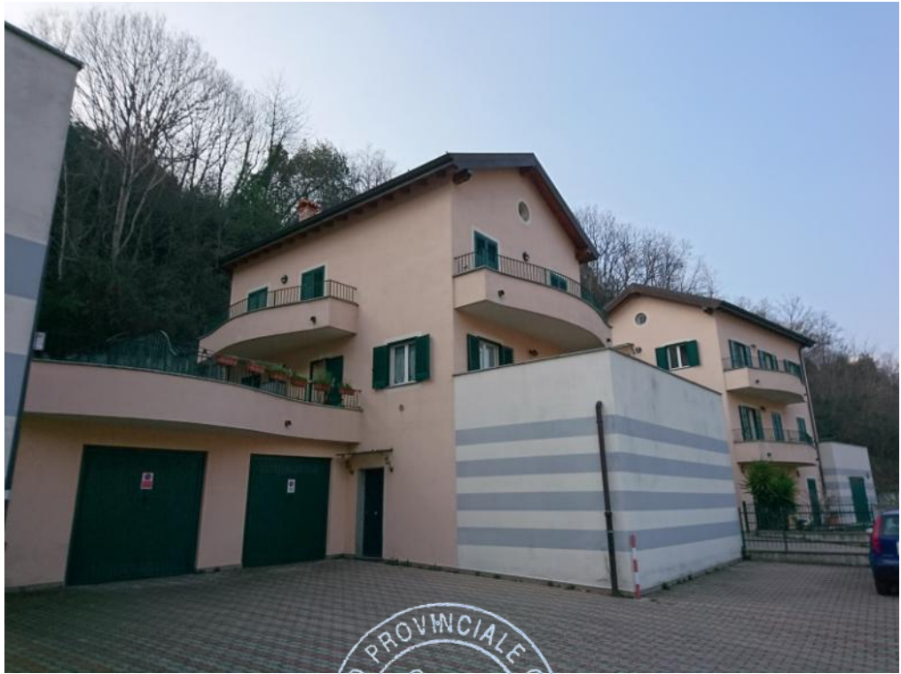
FOTO N°. 1: Prospetti Sud-Est
