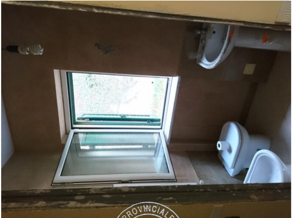
FOTO N°. 15: Bagno Ovest
