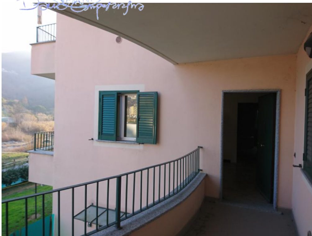
FOTO N°. 8: Porta d'ingresso Interno 3
