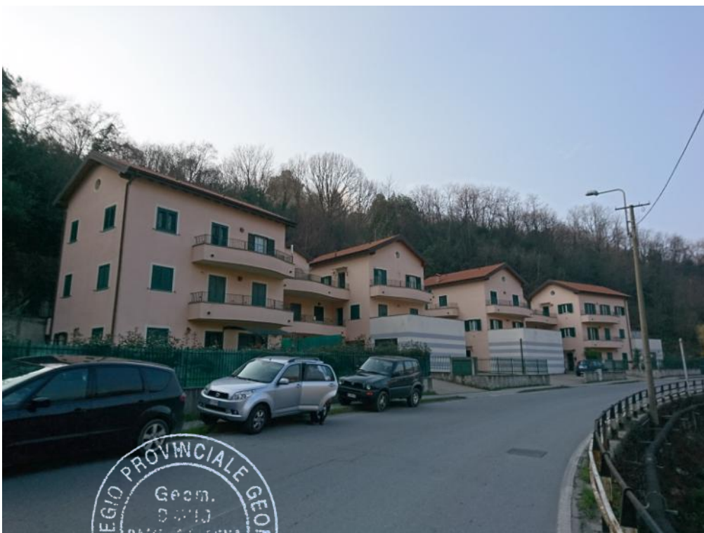
FOTO N°. 1: Prospetti Sud-Est
