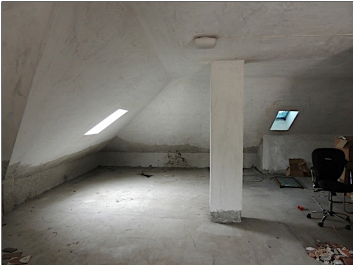
Foto 9 –lati sud ed ovest con lucernari
