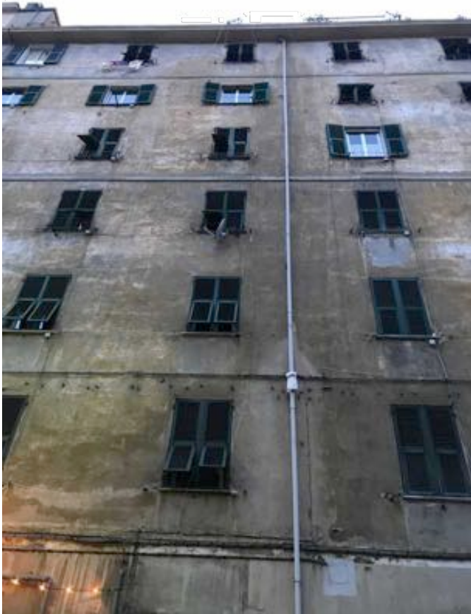
FACCIATA SU VIA DEL LAGACCIO
