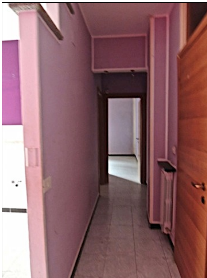
Foto 7 – corridoio, sullo sfondo in alto il trave passante dalla camera B, che attraversa il corridoio, dissimulato con due faretti
