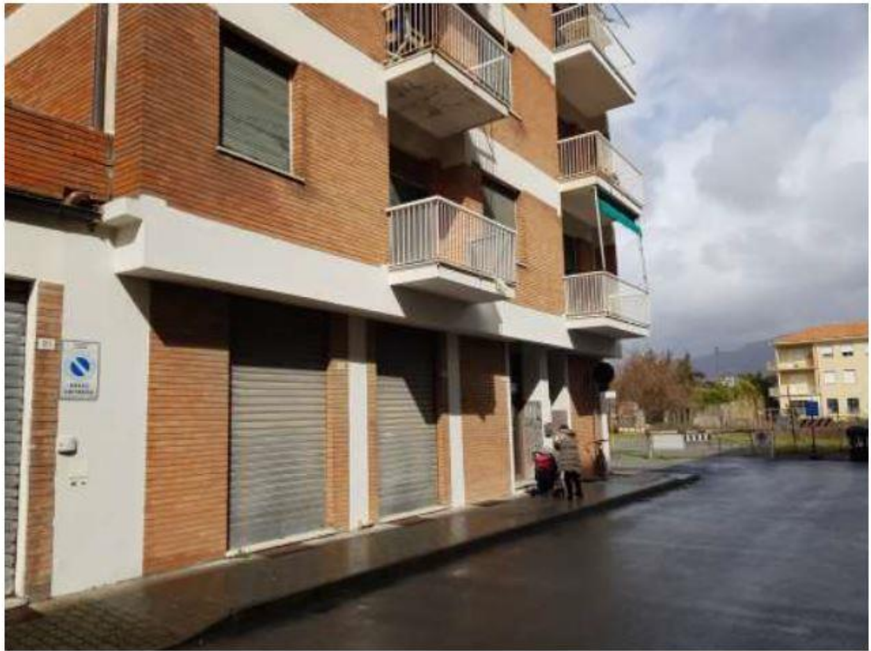
FOTO 1—PROSPETTO SU VIA PAGGI—SERRANDE CIVV. 83-85
